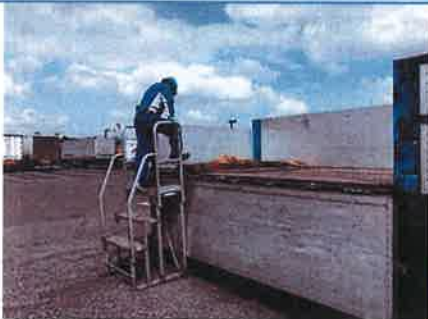
墜落・転落防止：昇降台の導入
